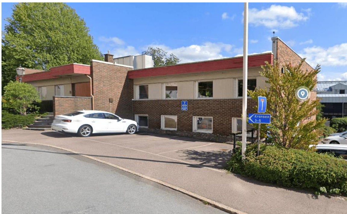
Figur 16: Befintlig byggnad från 1970-talet. Bild från google maps.
